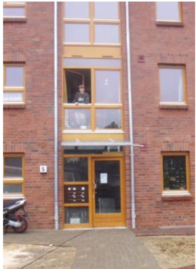
Angekommen im Brachvogelweg Eingang Westflügel Hof A, Niedrigenergiehaus
