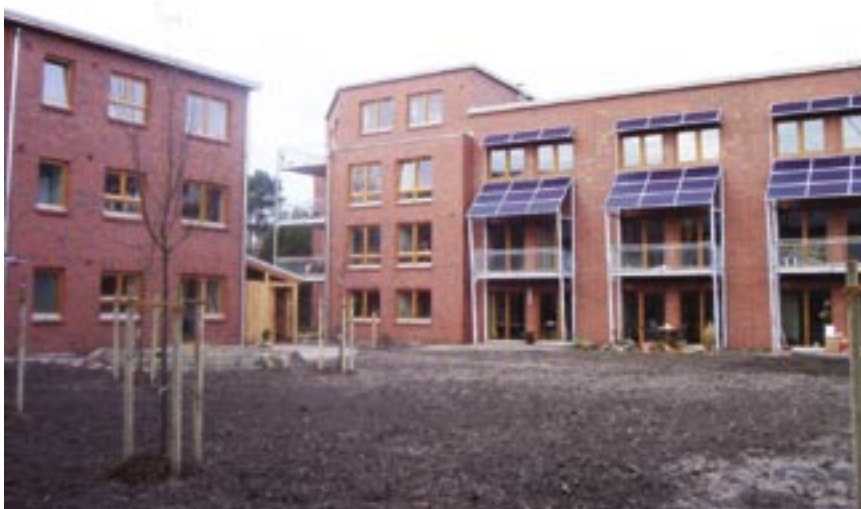
Gebäudeansichten im Innenhof B
