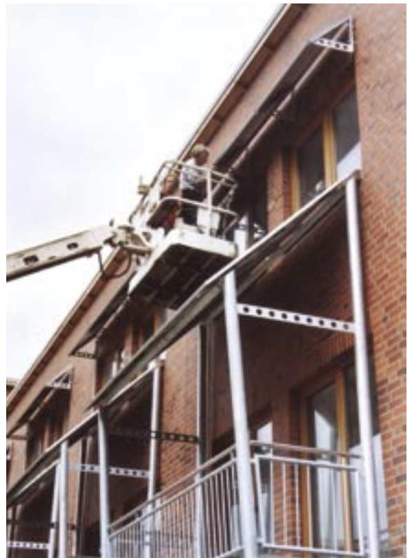
Fa. microsol montiert die Photovoltaik-Elemente auf den Vordächern der Passivhäuser
