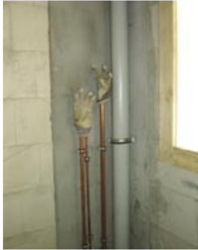
Luftdichtheit durch vorgezogenes Verputzen hinter Installations-schächten
