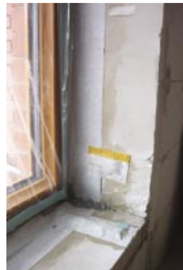
Fensterdetail in Planung und Ausführung: Die Abdichtung der Fenster erfolgte mit Butylband, die Befestigungsschienen wurden zusätzlich abgedichtet.
