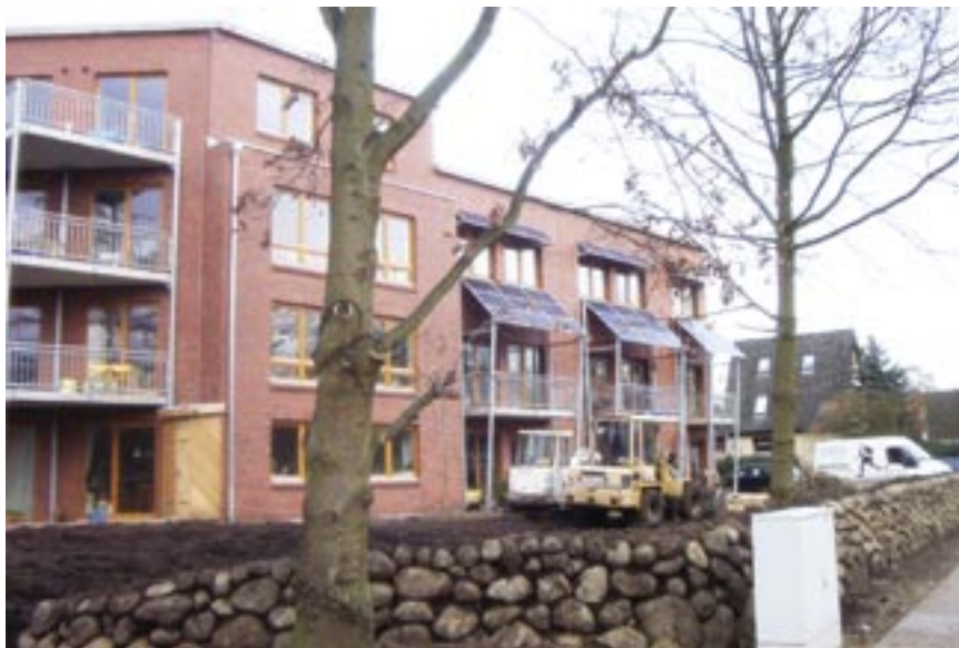
Eingangsansicht der Siedlung Brachvogelweg von Südwest
