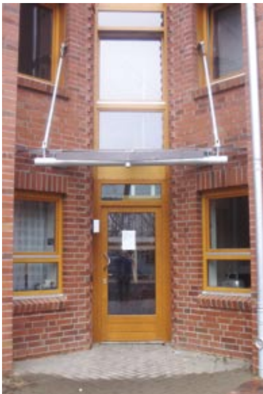
Eingang in das Eckgebäude: Fenster und Treppenelemente, Niedrigenergiehaus
