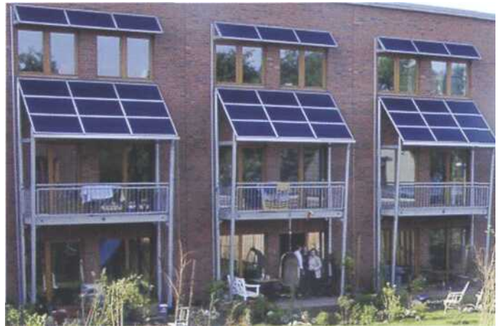
Südansicht: Die großen, bodentiefen Südfenster bringen einen Energieeintrag ein. Die Balkone stehen eigenständig und thermisch getrennt vor der Fassade.
