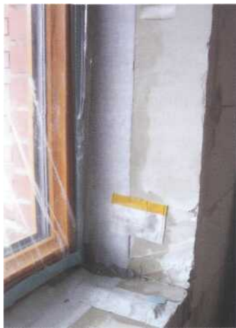
Bild 2/Detailzeichnung 1 und 1.1: Fensterdetail in Planung und Ausführung: Die Abdichtung der Fenster erfolgte mit Butylband, die Befestigungsschienen wurden zusätzlich abgedichtet.
